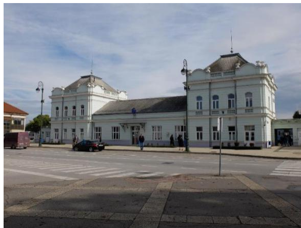
Slika.3: Željeznički kolodvor Varaždin
