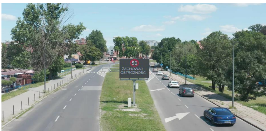
Slika 18. Znakovi s promjenjivim porukama s jasnim informacijama za vozače
