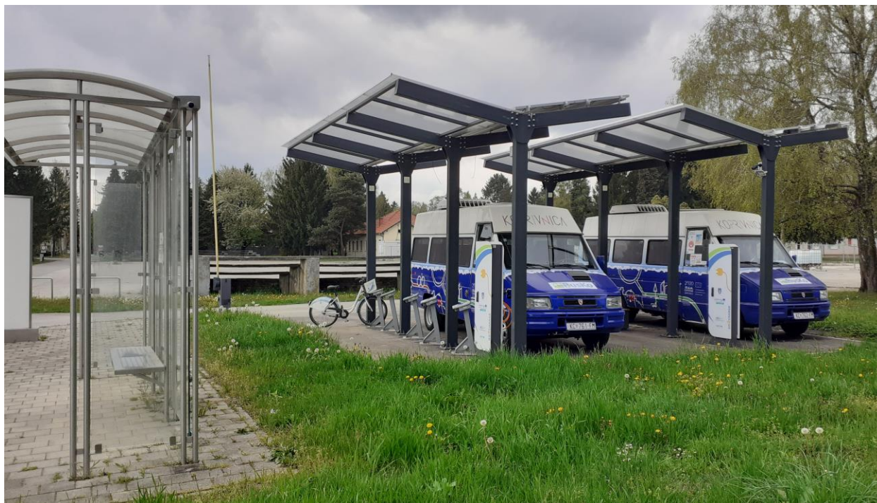
Slika 3.4 'Terminal javnih bicikala i električnih autobusa u gradu Koprivnici, Hrvatska',
