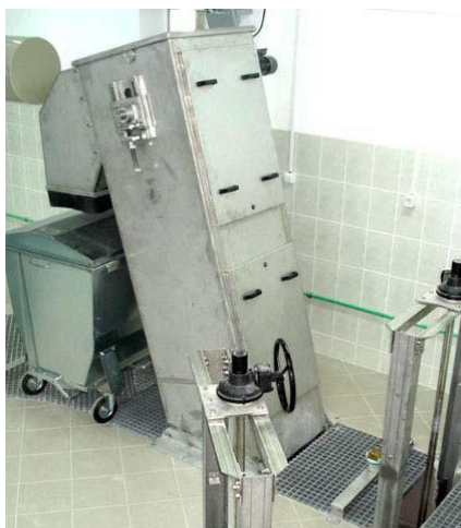
Slika 4.2. Primjer automatske grube lančane rešetke [19]
