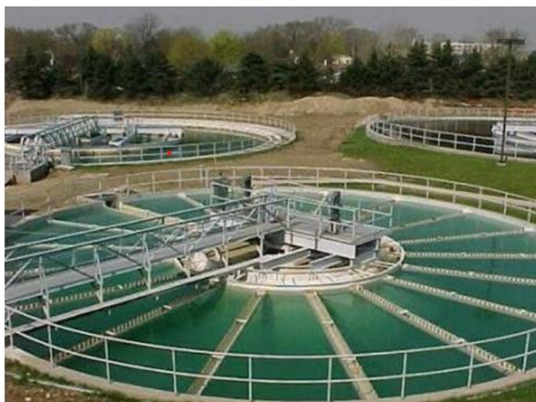
Slika 4: Primjer kružnog taložnika [7]
