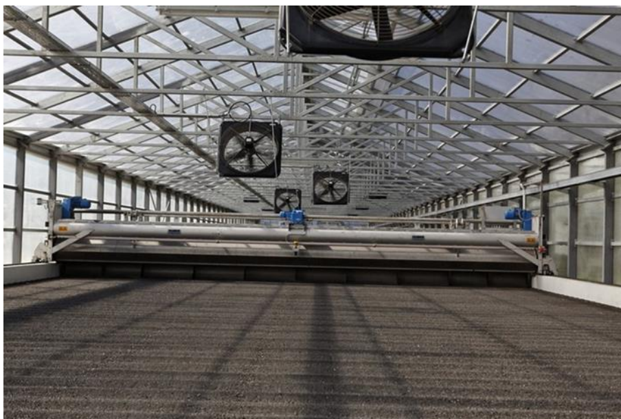
Slika 15: Staklenik za solarno sušenje mulja s fiksnim zgrtačem mulja [5]
