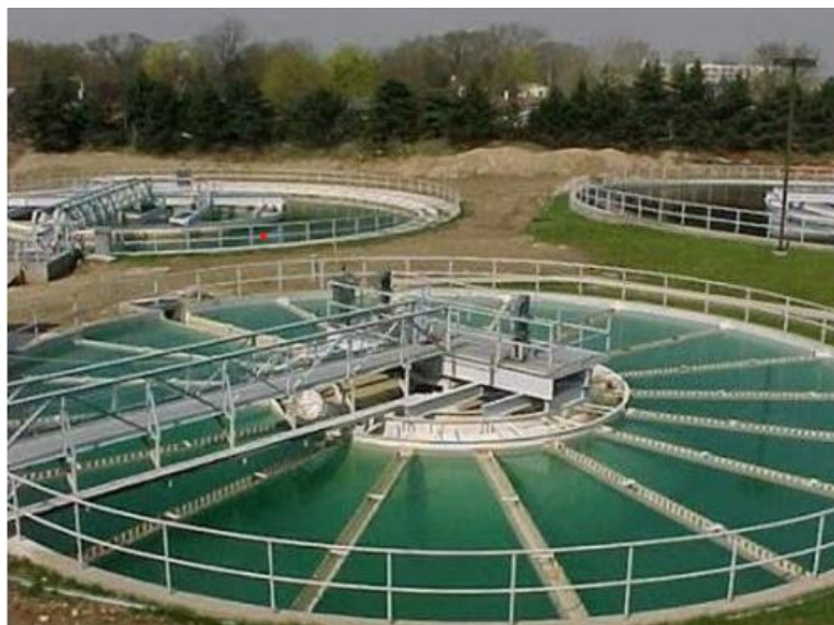
Slika 4: Primjer kružnog taložnika [7]
