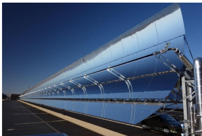
Slika 1.5; Parabolički sustavi korita [12]
