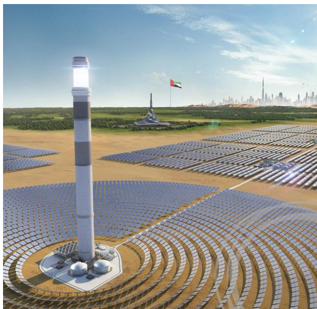
Slika 1.3; Heliostatski toranj solarne energije [10]
