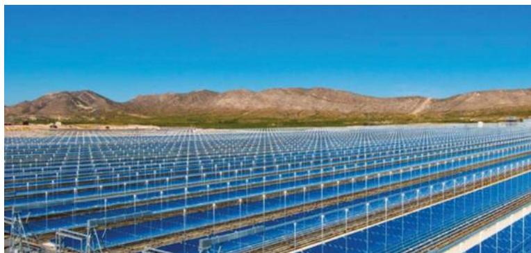
Slika 1.4; Linearni Fresnel kolektori [11]
