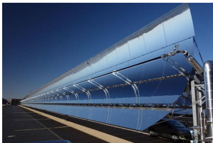
Slika 1.5; Parabolički sustavi korita [12]
