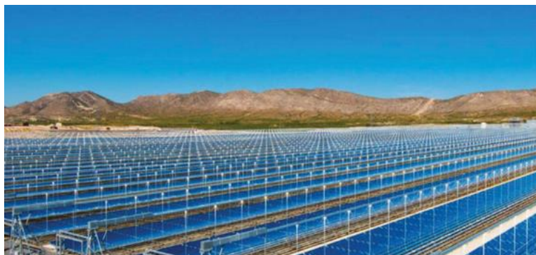
Slika 1.4; Linearni Fresnel kolektori [11]
