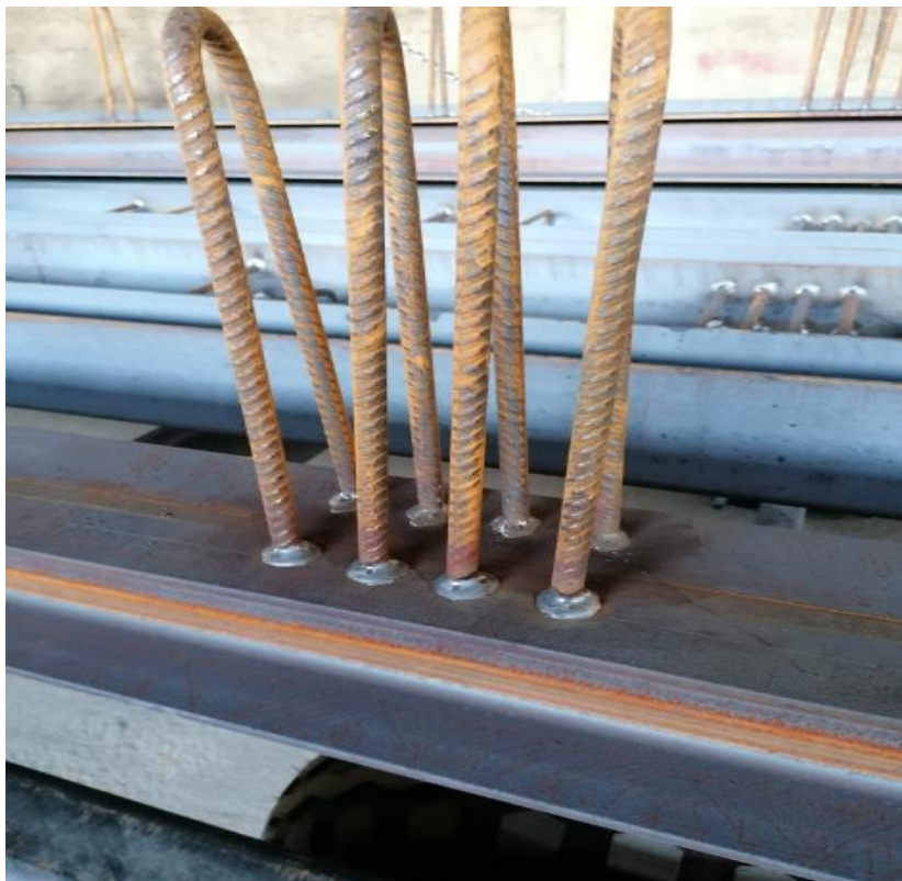
Slika 5.4 Očišćene i osušene površine zavarenog spoja
