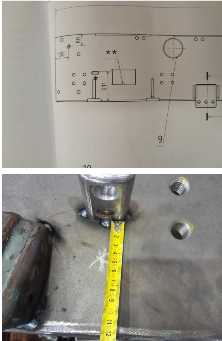
Slika 5.3. Dimenzijska kontrola postavljene pozicije[19]
