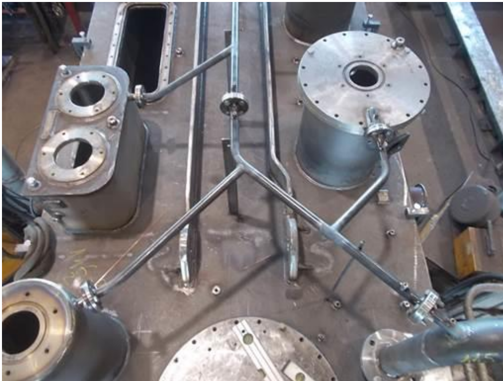
Slika 5.5. Probna montaža kotla D&ST[19]
