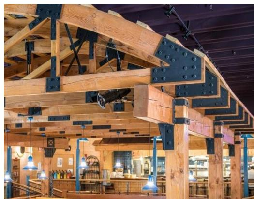
*Slika 71. Spojne ploče [16]*
