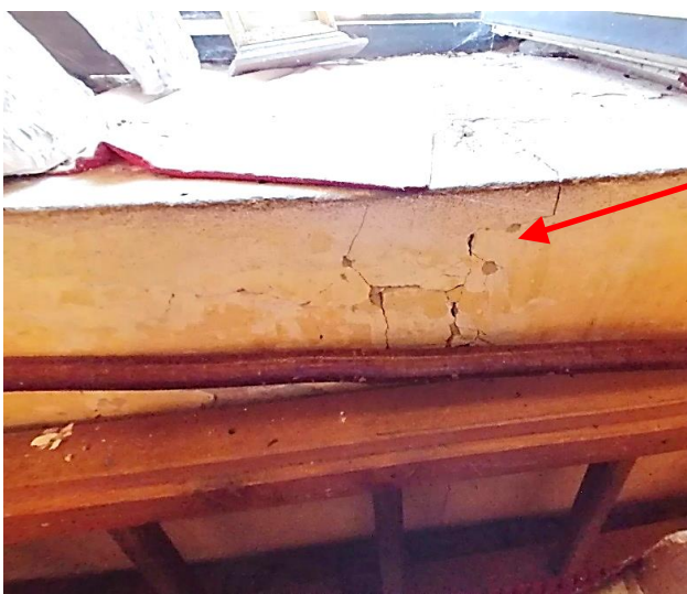
Slika 38. Pukotine na luku (istočni dio kora) te produžetak pukotine nad prozorom (zapad)
