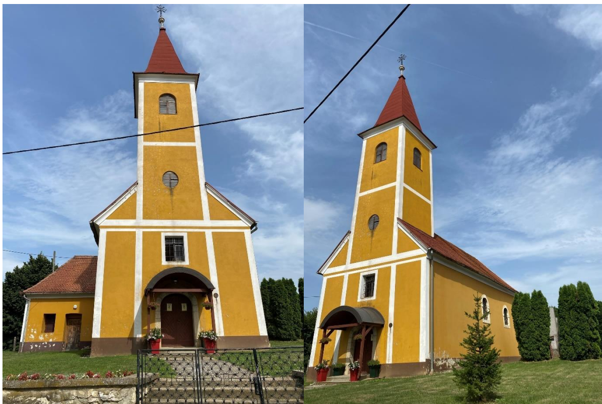
Slika 8. Zapadno pročelje Kapele sv. Jakoba
