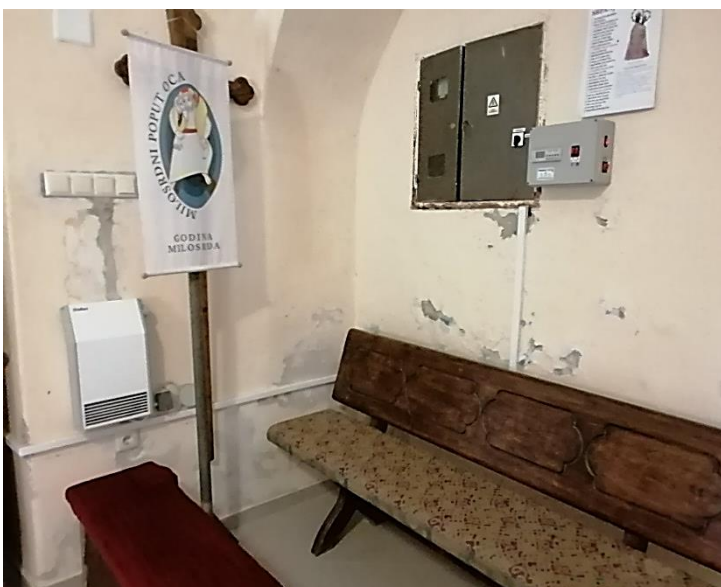
Slika 41. Vlaga i pukotinsko oštećenje svoda sakristije
