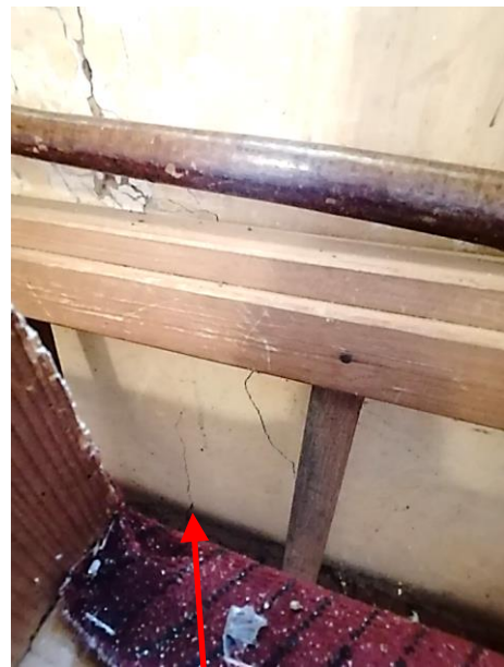
Slika 38. Pukotine na luku (istočni dio kora) te produžetak pukotine nad prozorom (zapad)
