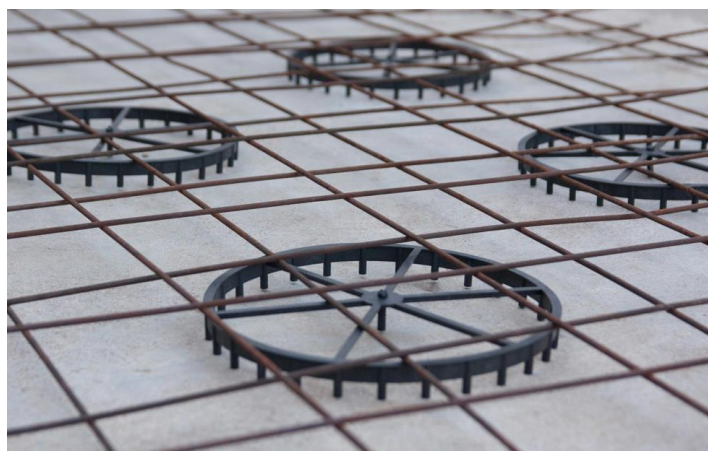
Slika 4.2.2. upotreba odstožnika armaturne mreže [5]
