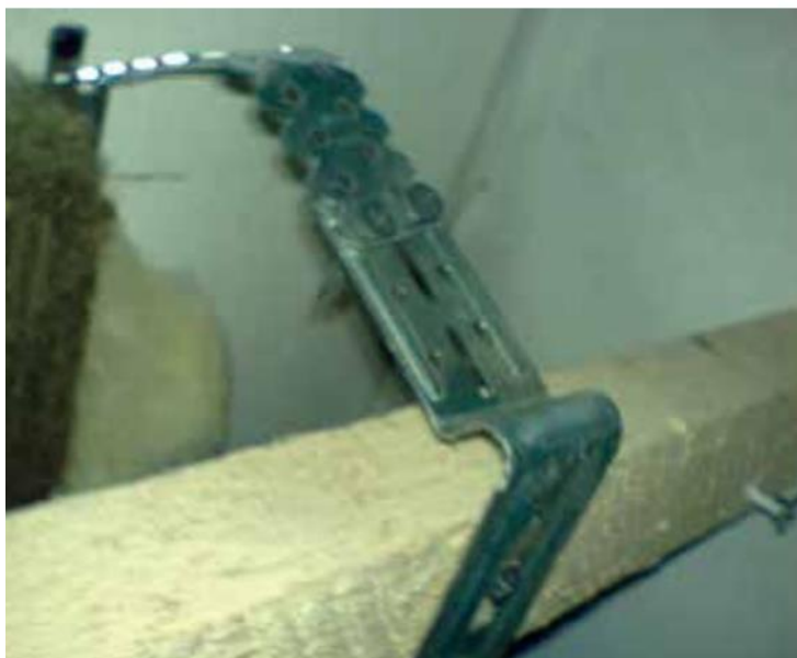
Slika 61. Pogrešan ovjesni element ( prilagodljiv ovjesni nosač produžen direktnim ovjesom) [33]
