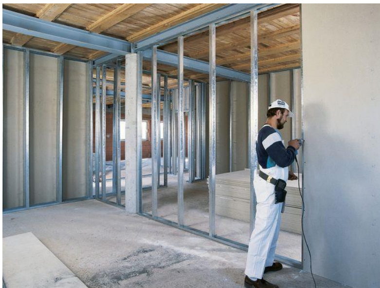
Slika 1. Suhomontažni radovi [1]
