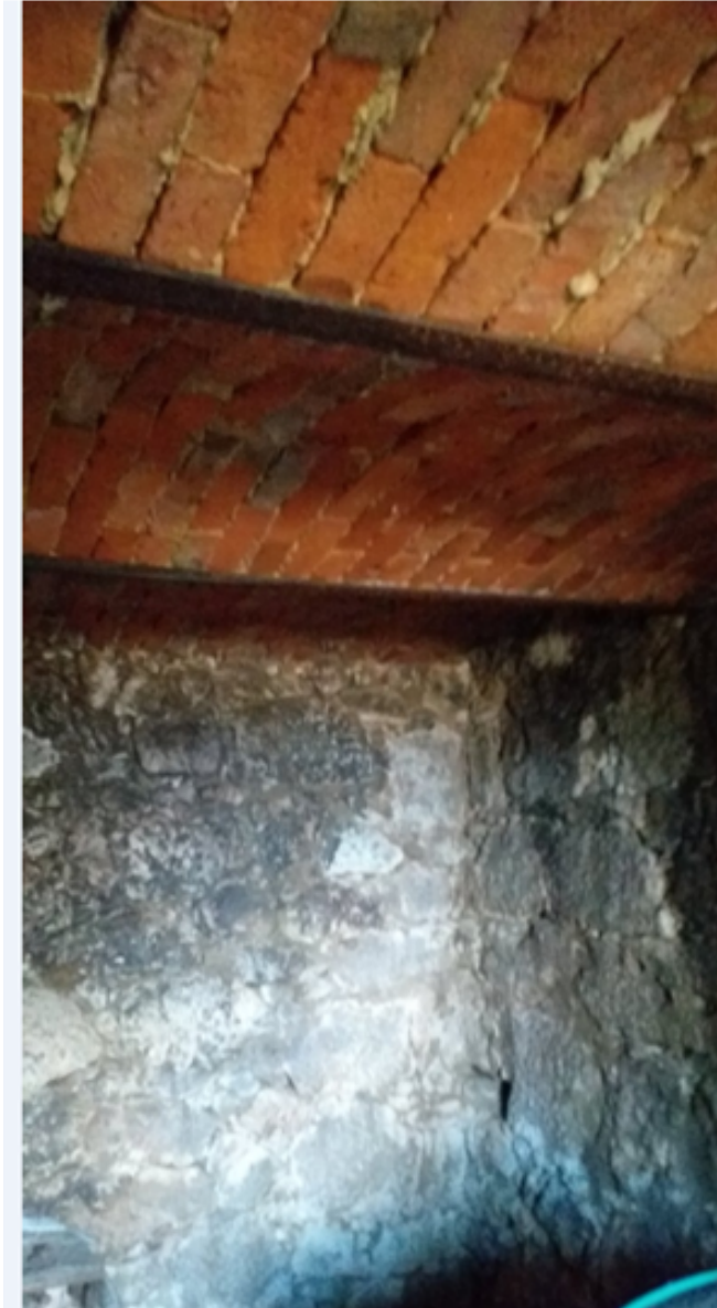
Slika 5.6. Bačvasti svod i željezno ojačanje
