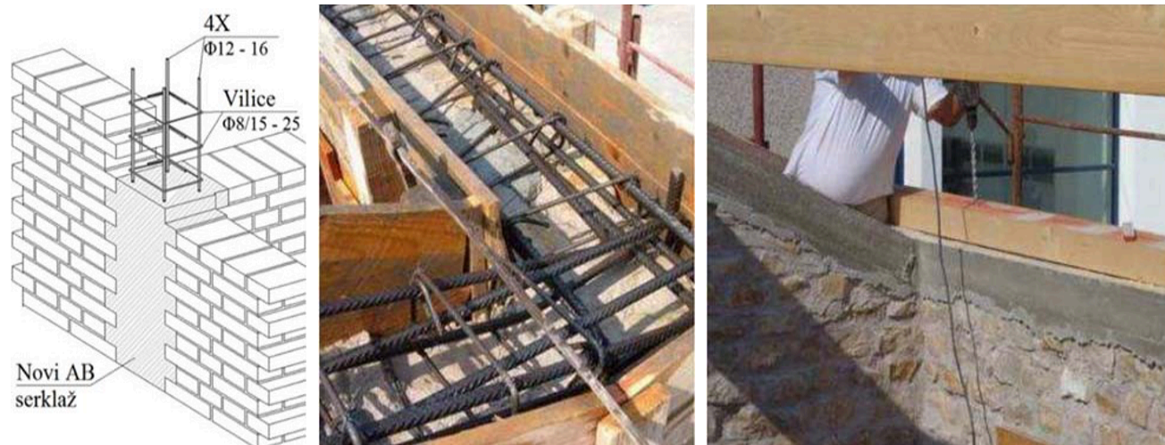
Slika 7.5. Prikaz vertikalnog i horizontalnog serklaža
