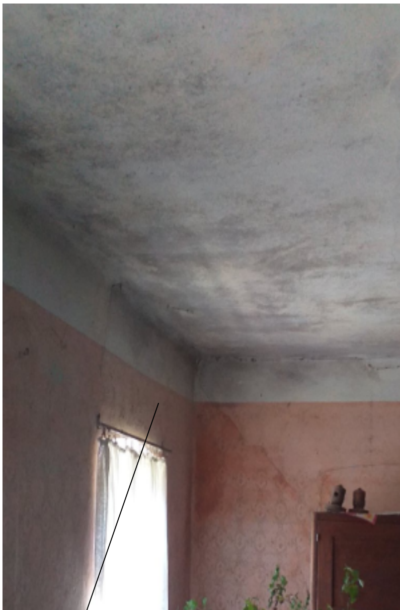
Slika 5.23. Prikaz vlage – (oznaka na tlocrtu 1a)
