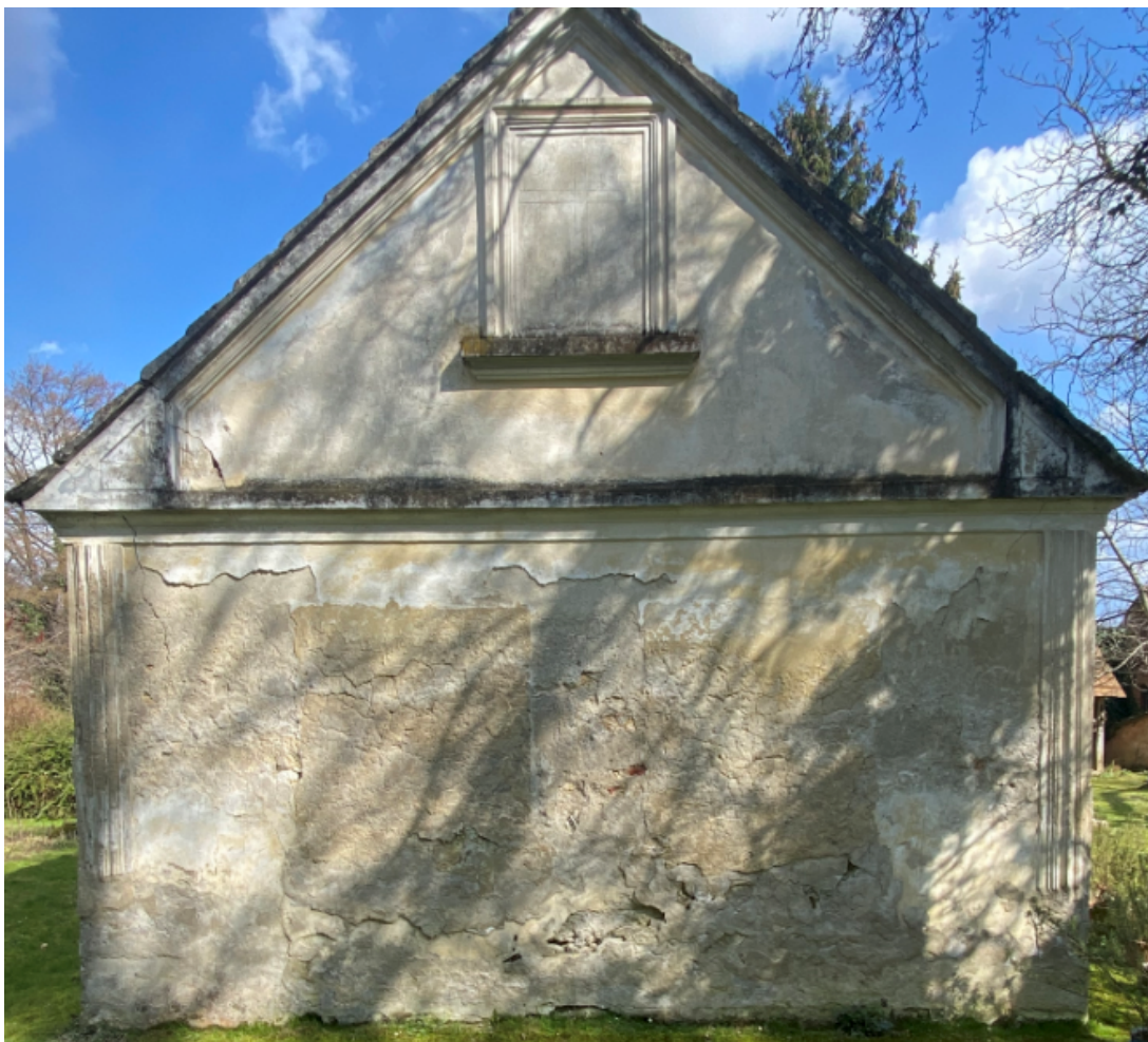
Slika 5.7. Prikaz štukatura na zapadnom zidu
