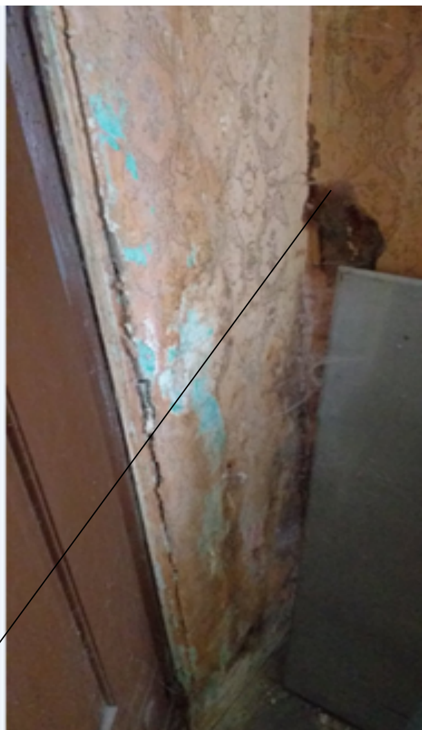
Slika 5.22. Prikaz plijesni na vanjskom zidu, jug- (oznaka na tlocrtu 1c)
