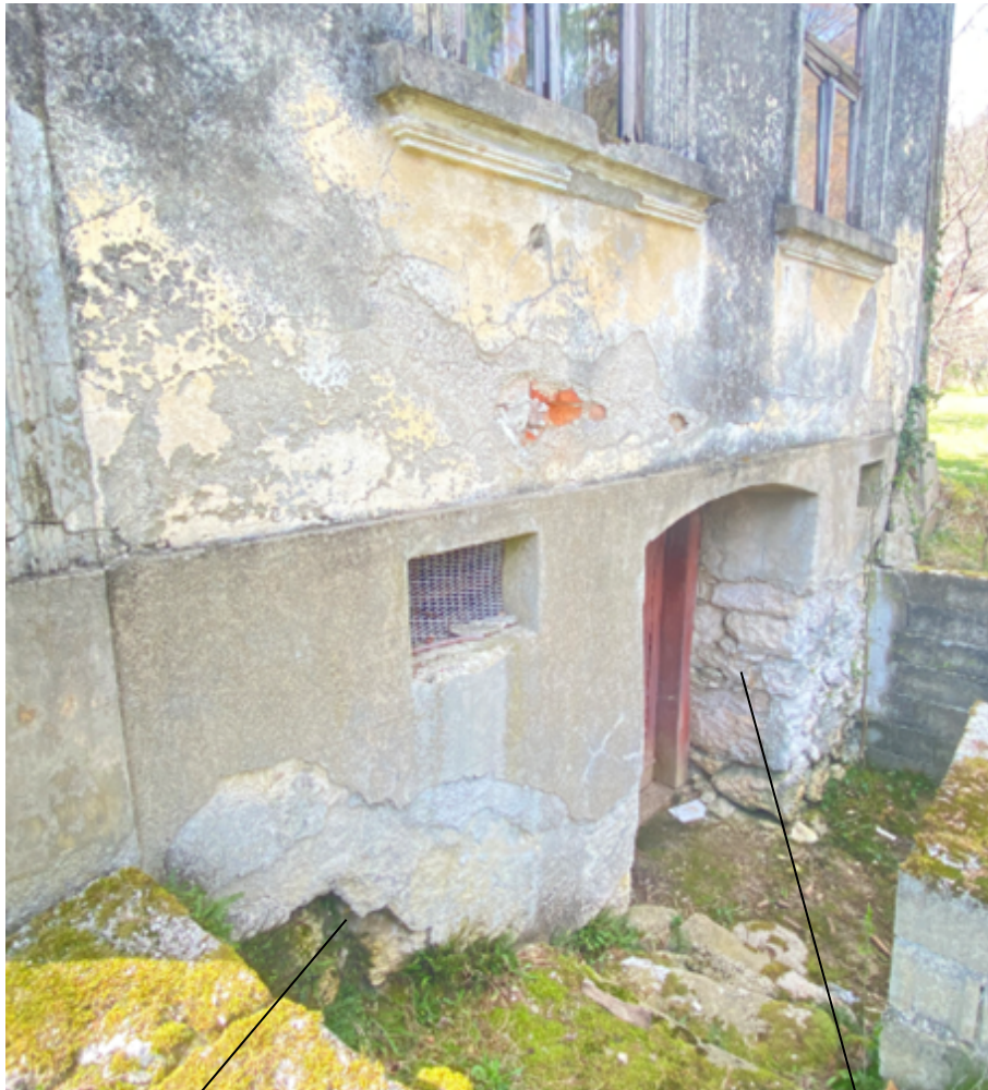
Slika 5.15. Istočno pročelje-zidovi podruma
