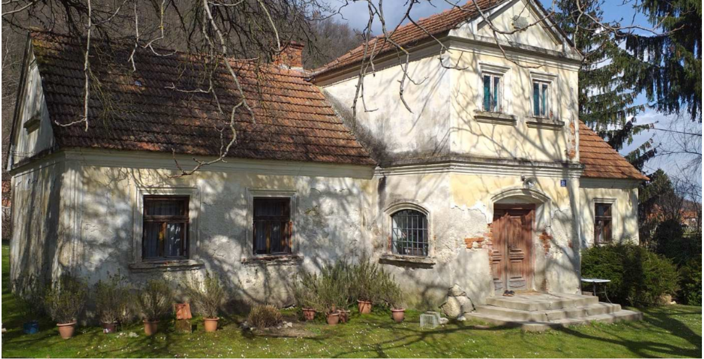
Slika 5.4. Prikaz južnog pročelja
