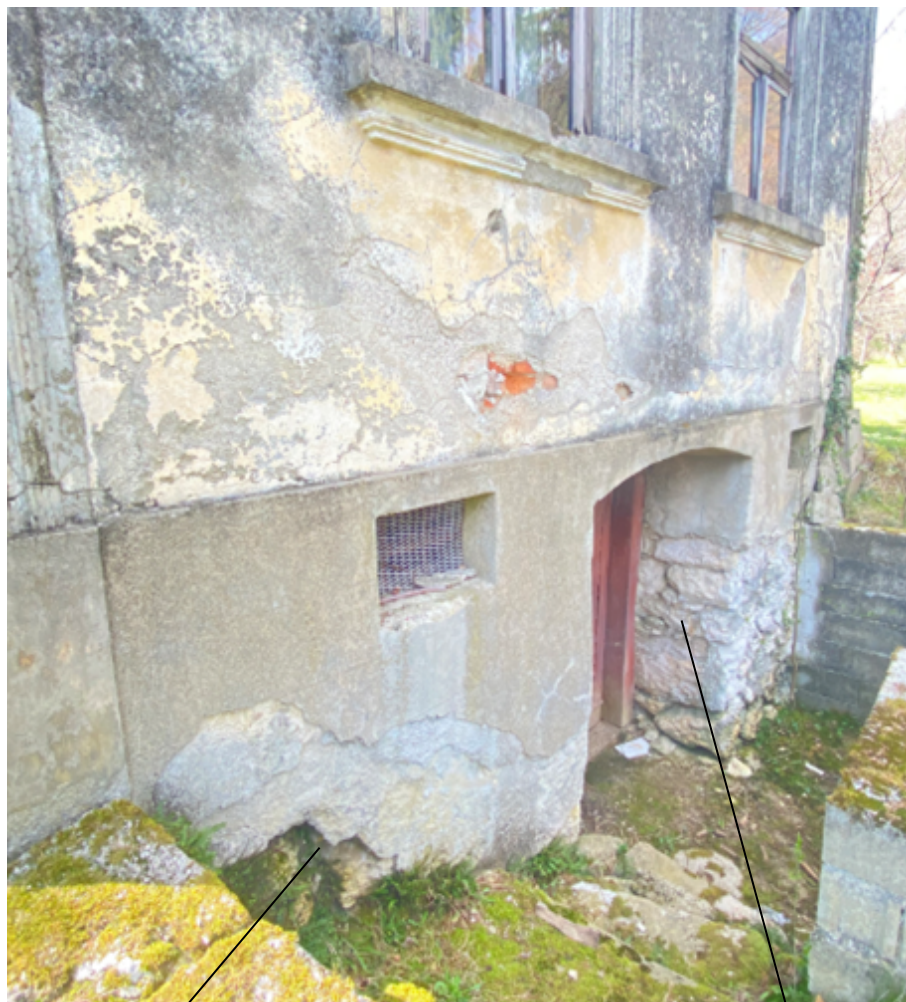
Slika 5.15. Istočno pročelje-zidovi podruma
