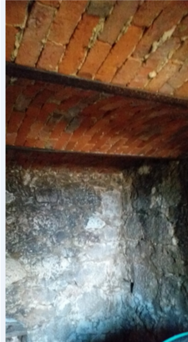
Slika 5.6. Bačvasti svod i željezno ojačanje
