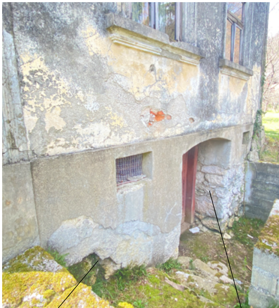
Slika 5.15. Istočno pročelje-zidovi podruma
