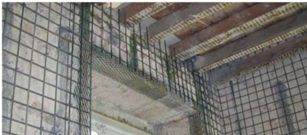
Slika 3.6. Pojačanje armiranim slojem betona
