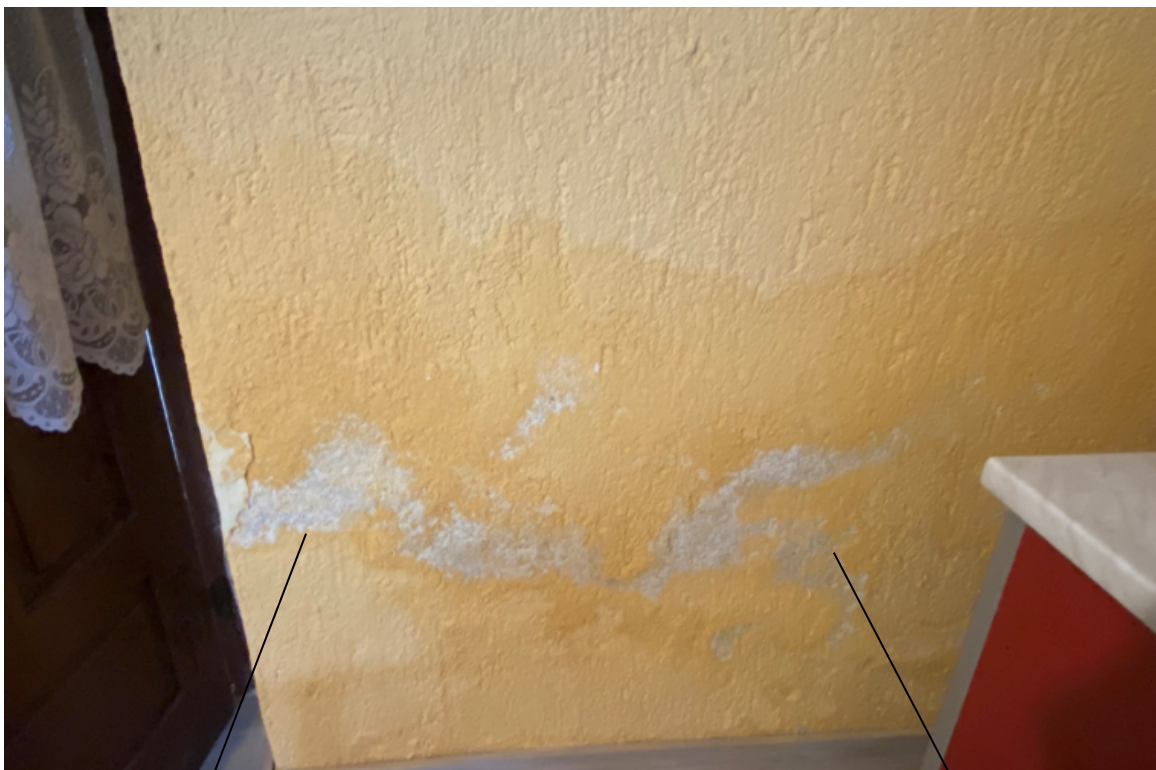
Slika 5.26. Prikaz vlage sa druge strane zida slike 5.25.- (oznaka na tlocrtu 3a)
