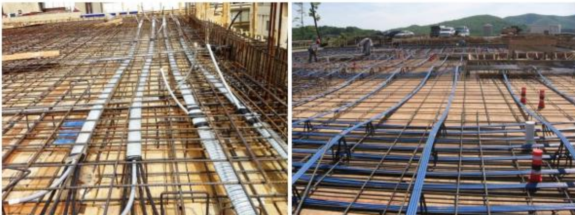
Slika 9: Primjer ploče s „bonded“ i „unbonded“ kabelima
