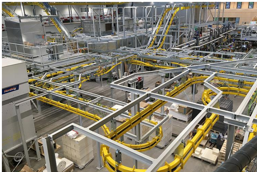
Slika 18. Proizvodnja metalnih konstrukcija
