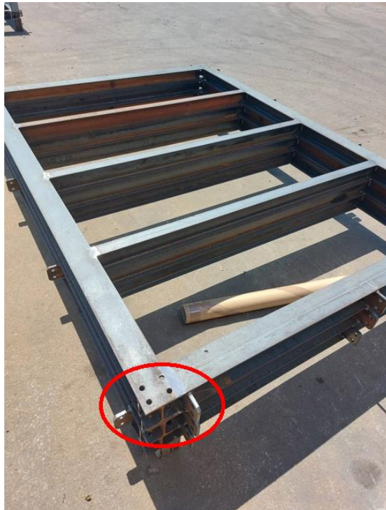
Slika 5.16 Zavarena podkonstrukcija balkona
