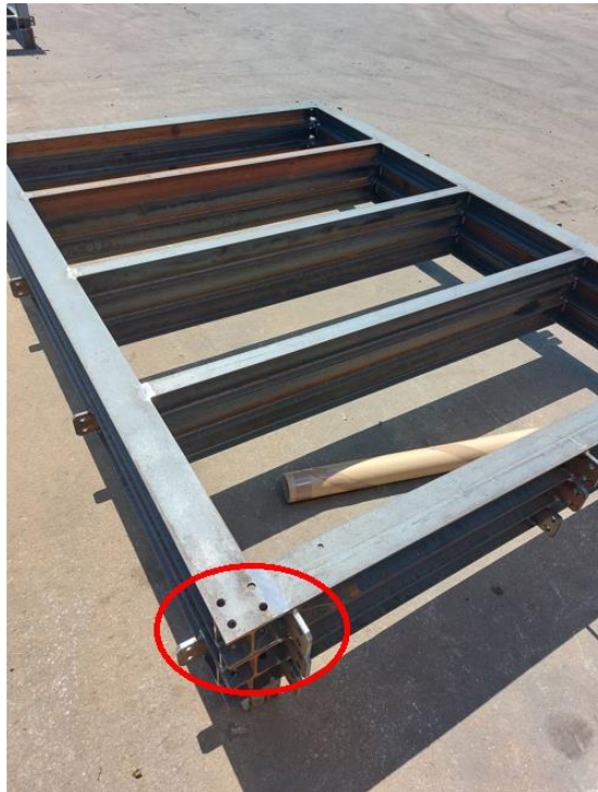
Slika 5.16 Zavarena podkonstrukcija balkona
