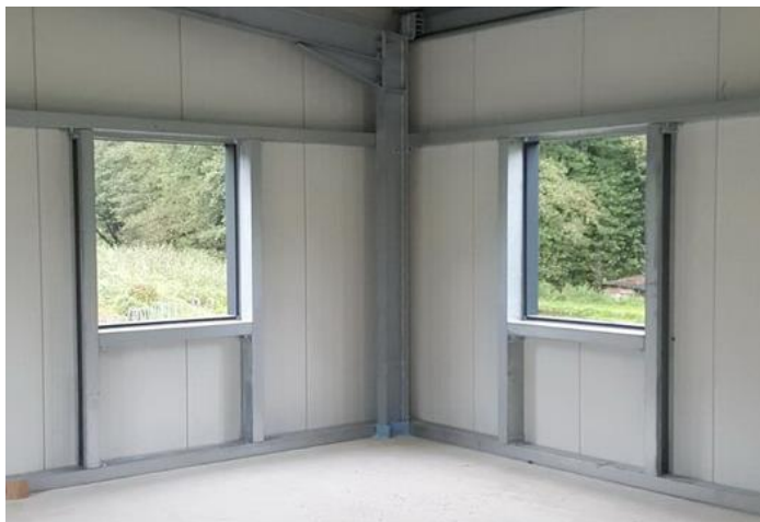
Slika 17: Nosiva čelična konstrukcija fasade i prozora
