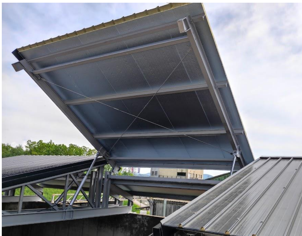
Slika 15: Podizni čelični krov sa sendvič panelima
