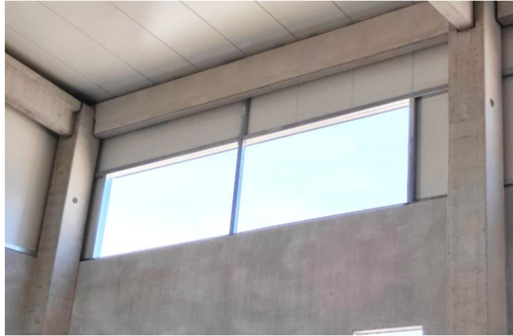
Slika 20: Nosiva konstrukcija fasadnih sendvič panela
