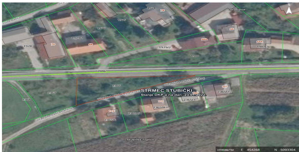
Slika 3. Položaj lokacije klizišta na županijskoj cesti oznake Ž2217 Stubičke Toplice
