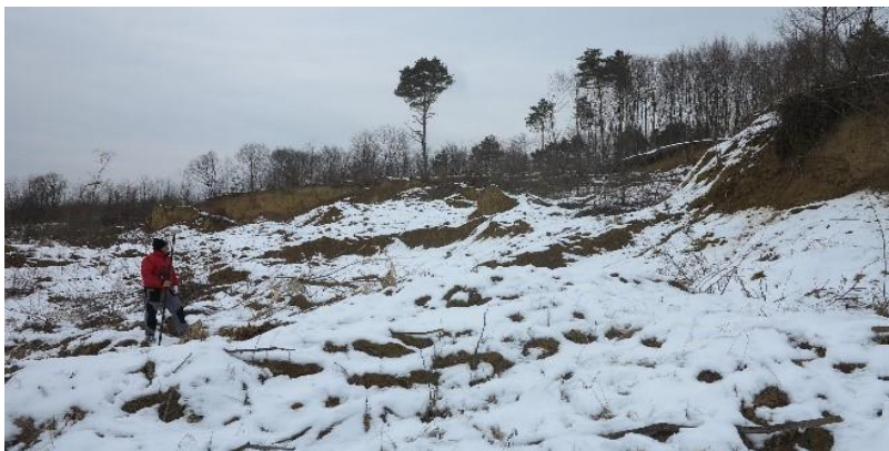
Slika 17: Iskolčenje pozicijskih točaka na osi budućeg nožićnog nasipa, u cilju provedbe kontrolnog dinamičkog sondiranja(LUS-DPL)[1]
