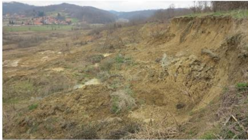
Slika 1: Pogled preko čela devastiranog glinokopa s pristupne toče u smjeru sjever-sjeverozapad[1]
