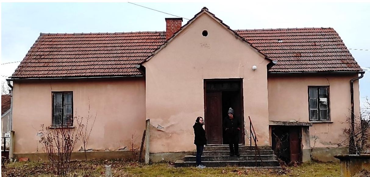
Slika 4.9 - Južno pročelje - šteta od kapilarne vlage
