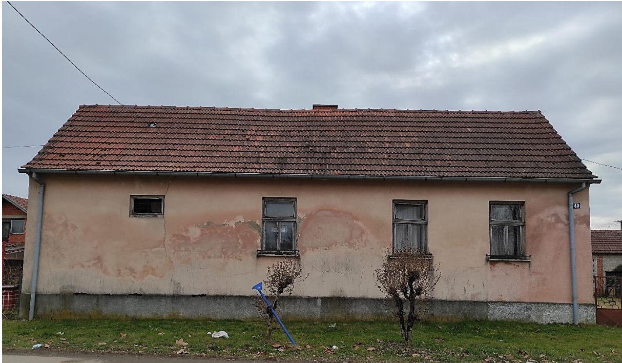
Slika 1.1 - Obiteljska kuća u Pušćinama, sjeverno pročelje, pogled sa ceste
