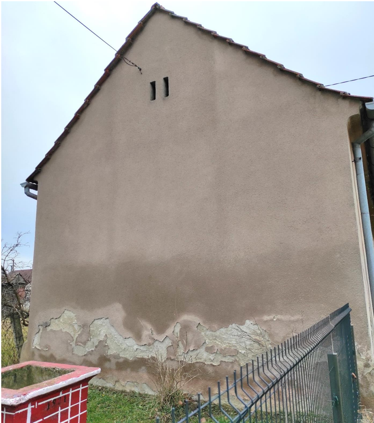
Slika 3.1 – Prikaz štete nastale kapilarnom vlagom na istočnom pročelju obiteljske kuće u Pušćinama
