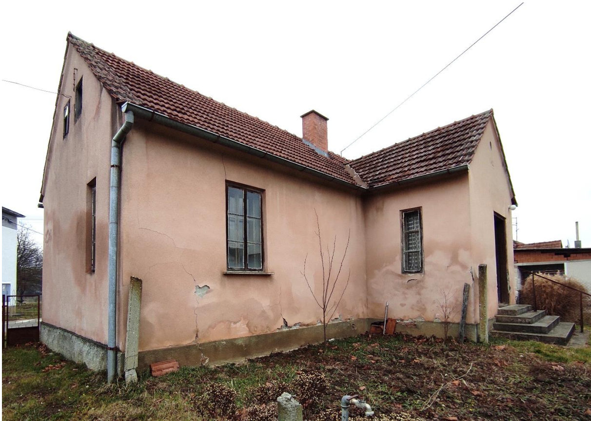
Slika 4.1 - Pogled na južno-zapadno pročelje obiteljske kuće
