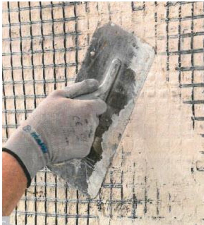
Slika 5.6. Shema izvedbe pojačanja FRCM sustavom
