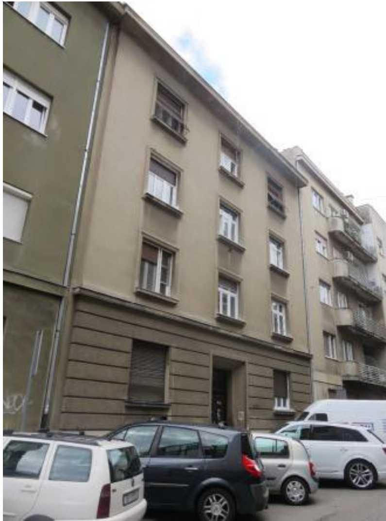
Slika 3.3. sjeverno pročelje zgrade
