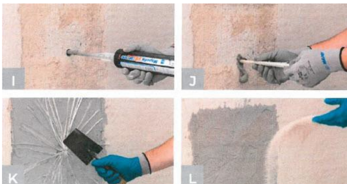
Slika 5.9. Sidrena užad Mapewrap Fiocco- postupak I-L
