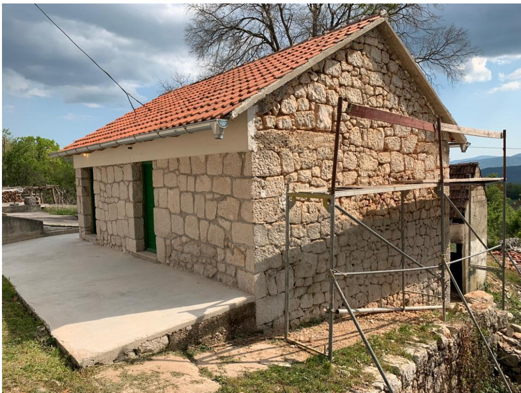
Fotografija 37: Obrada sljubnica –Obiteljska kuća Tolić [5]
