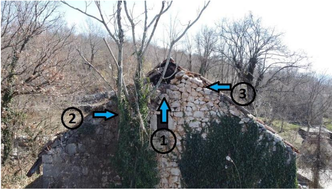
Fotografija 20: Oštećenje zabatnog zida (označeno sa br. 1), Oštećenje nastalo od divljeg bilja (označeno sa br. 2), Urušavanje zabatnog zida (označeno sa br. 3) [3]
