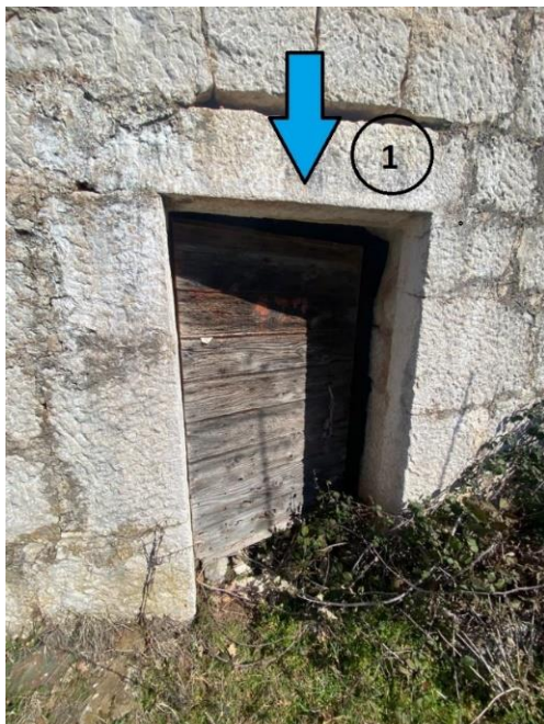
Fotografija 13: Oštećenja stolarije – prozora i vrata – označena sa brojevima 1 i 2 [3]
