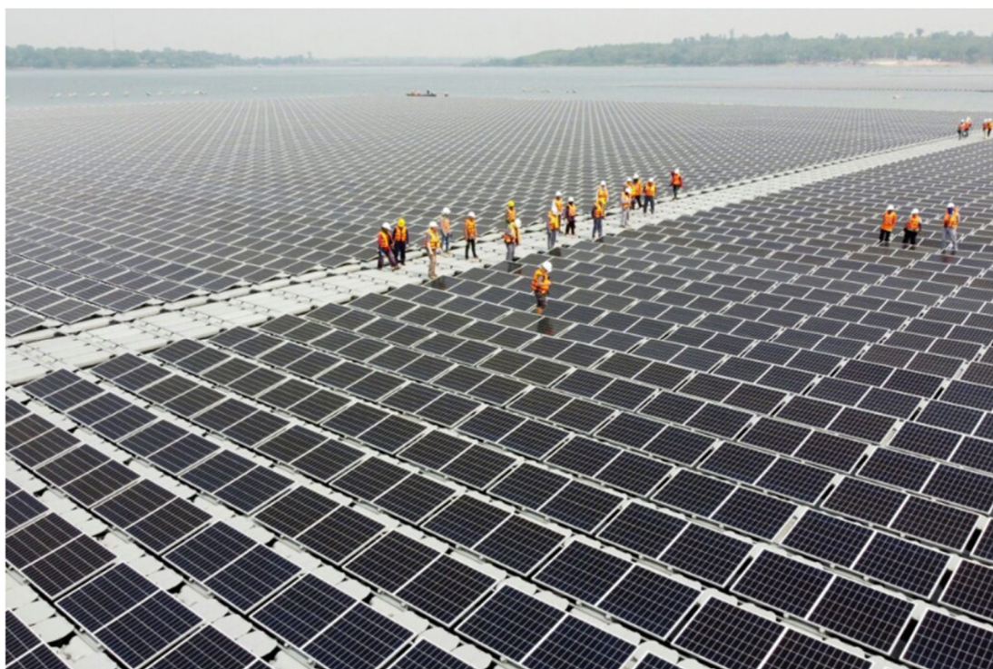
Slika 31 Primjer izvedenog sustava plutajućih solarnih fotonaponskih panela [22]
