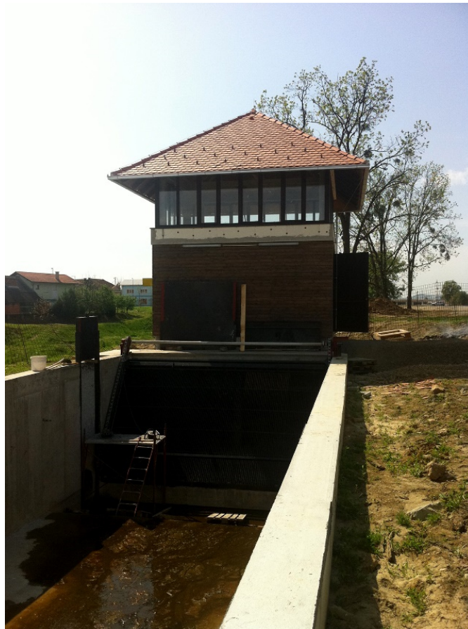
Slika 4 Mala hidroelektrana Pleternica [5]
