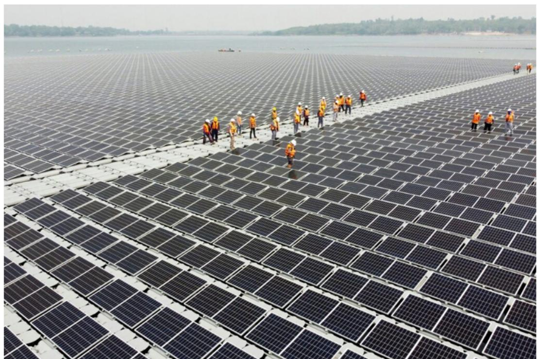
Slika 31 Primjer izvedenog sustava plutajućih solarnih fotonaponskih panela [22]
