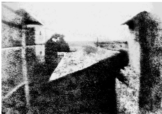
Slika 2 – Pogled kroz prozor
