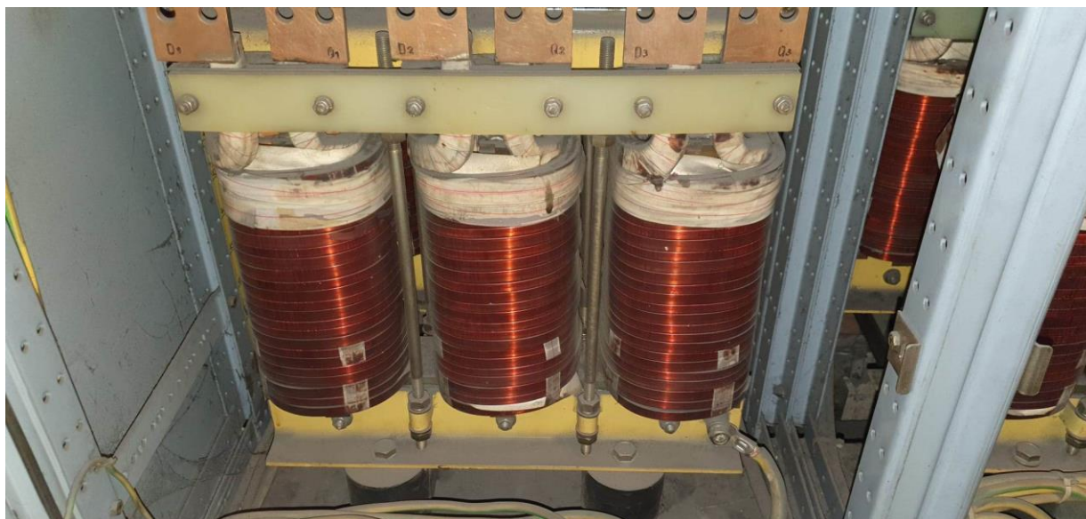
Slika 27. Trofazne kondenzatorske prigušnice
