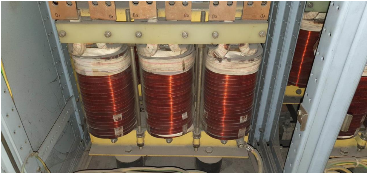
Slika 27. Trofazne kondenzatorske prigušnice
