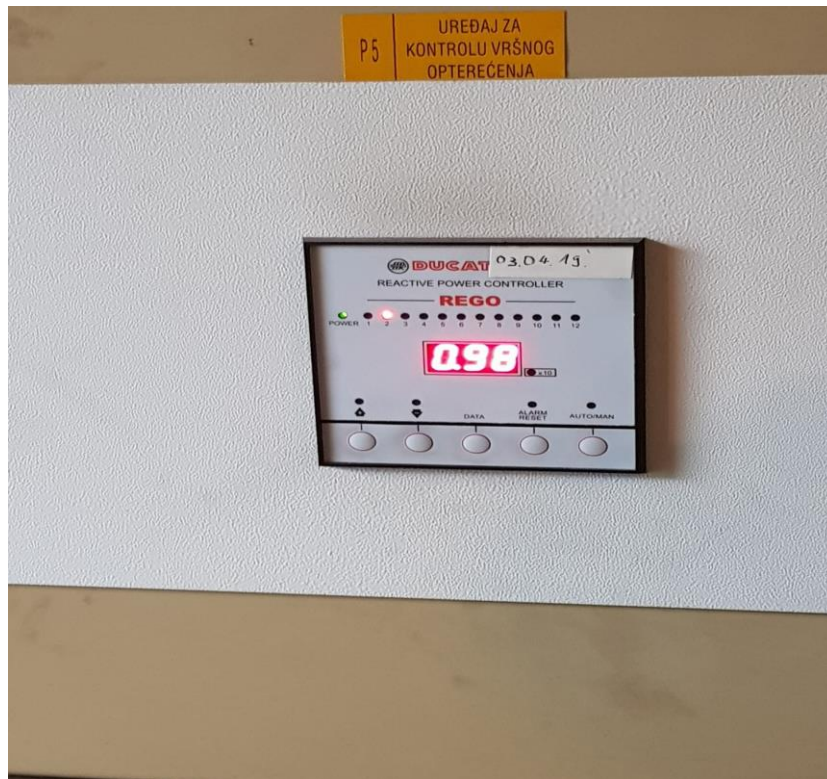
Slika 31. Regulator faktora snage
