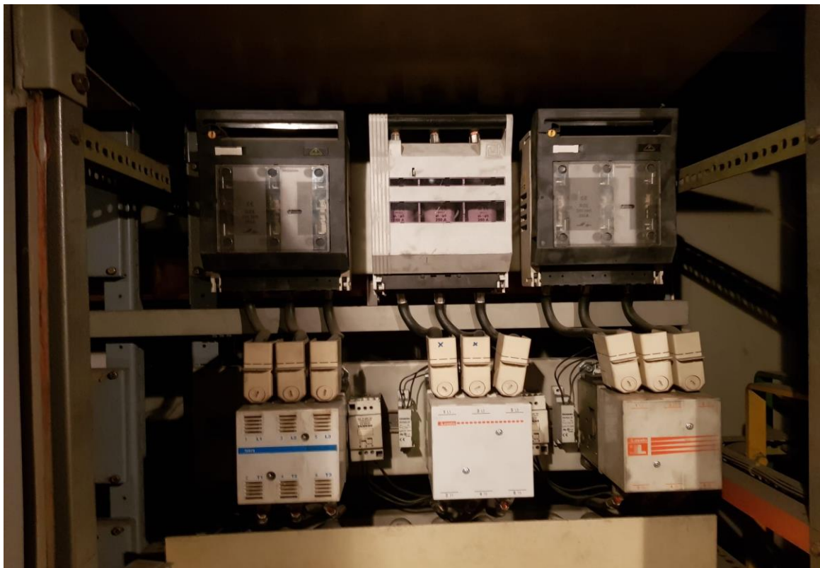
Slika 30. Kondenzatorski sklopnici
