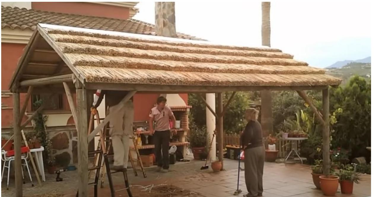
Slika 3.10. Prikaz krovišta napravljenog sa blokovima od trske [3]
