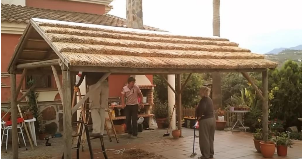
Slika 3.10. Prikaz krovišta napravljenog sa blokovima od trske [3]
