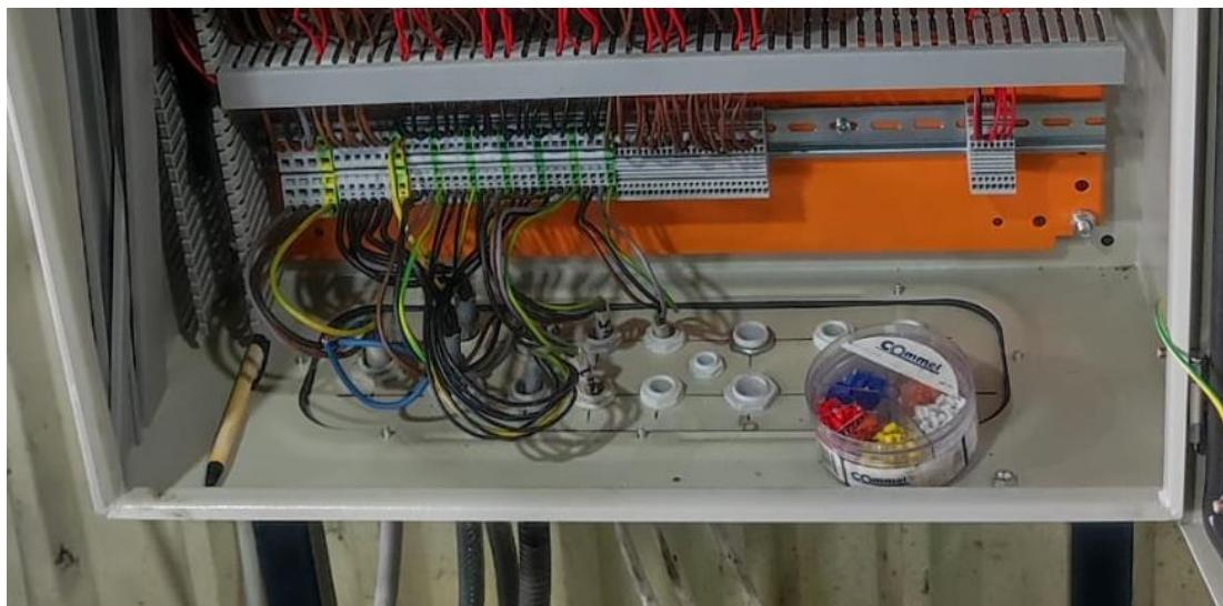
Slika 4.6. Prikaz spoja glavnog strujnog kruga
