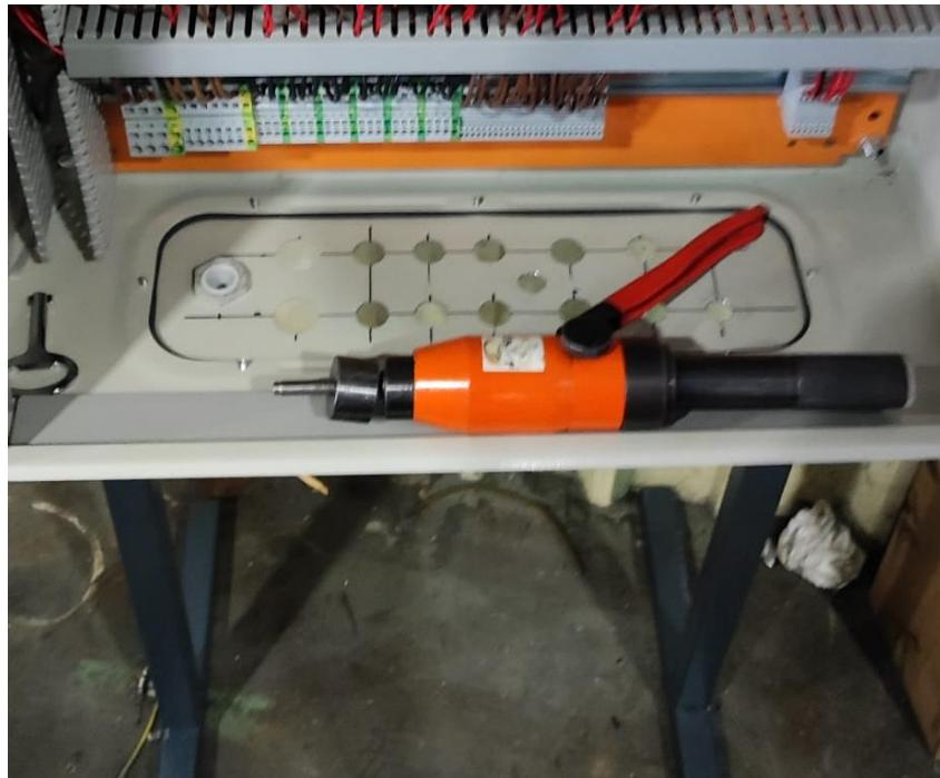
*Slika 4.4. Bušenje rupa za uvodnice prema nacrtanom rasporedu*
