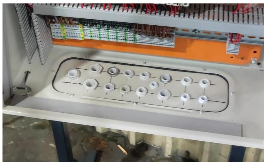
*Slika 4.5. Postavljene uvodnice u novom ormaru*
