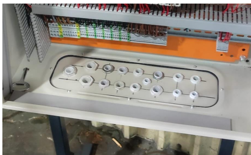
Slika 4.5. Postavljene uvodnice u novom ormaru
