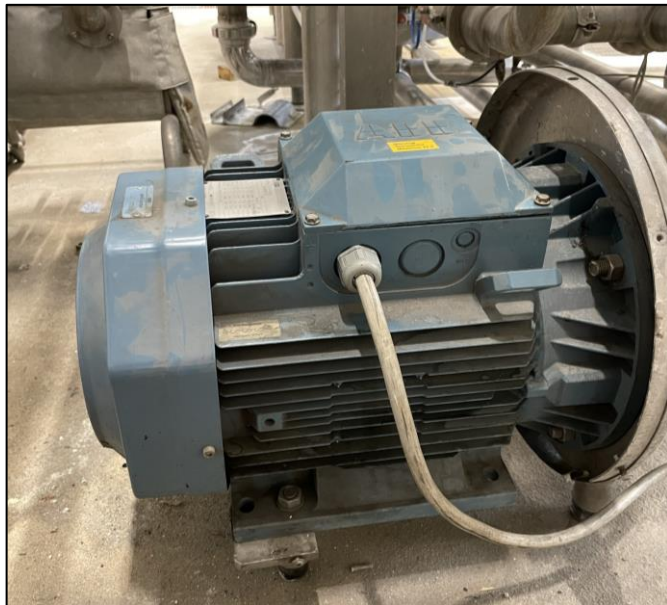
Slika 2.2 Asinkroni motor koji je dio CIP sustava
