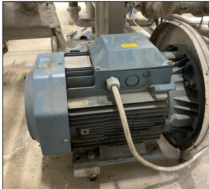
Slika 2.2 Asinkroni motor koji je dio CIP sustava
