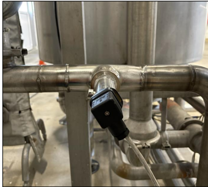
Slika 3.4 Pozicija transmitera tlaka
