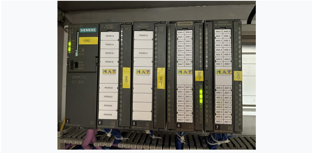
Slika 2.7 S7-300 i dodatni moduli
