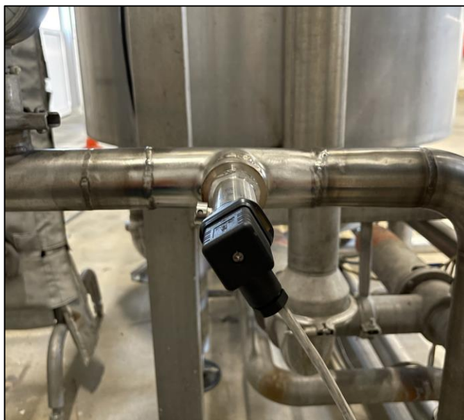
Slika 3.4 Pozicija transmitera tlaka
