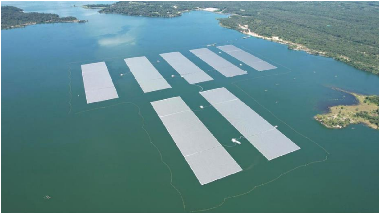
Slika 3.2. Plutajuća solarna elektrana [13]
