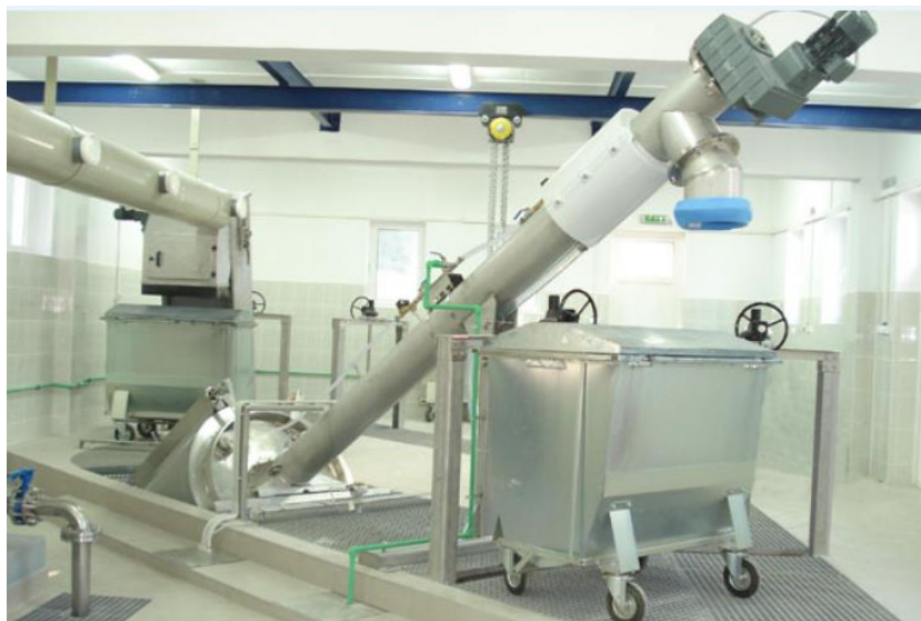
Slika 21. Automatska fina rotacijska rešetka [27]
