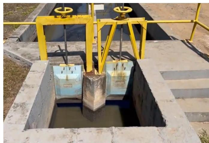
Slika 24. Ulazni bazen s vertikalnim pločastim zapornicama [30]
