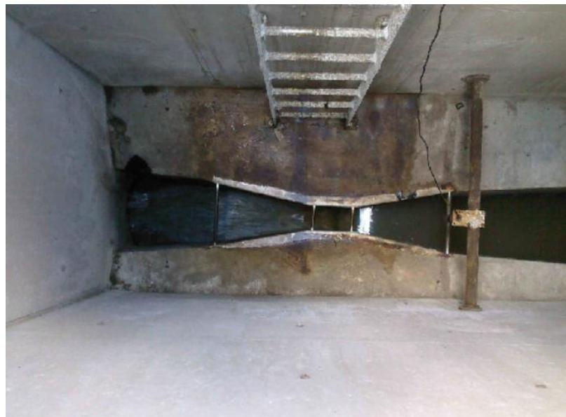
Slika 12. Parshallovo suženje instalirano na dovodnom kanalu [18]
