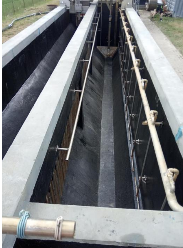
Slika 26. Aerirani pjeskolov-mastolov u izgradnji [31]
