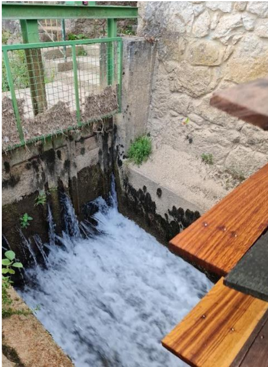
Slika 40. Prikaz ulaza vode u dovodni kanal preko zapornice [8]
