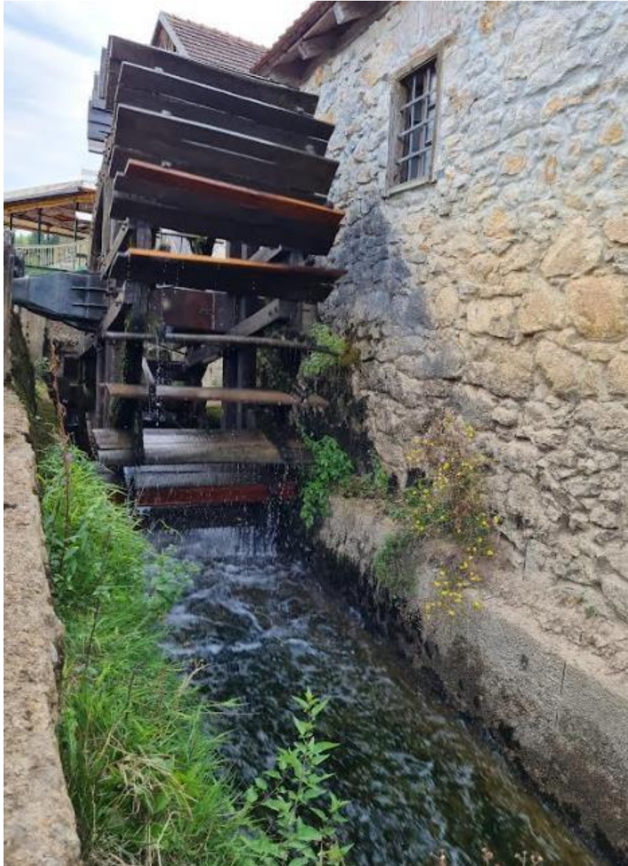
Slika 41. Prikaz izlaza dovodnog kanala [8]
