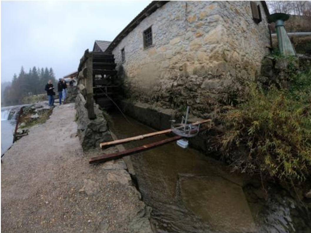
Slika 31. Postavljanje uređaja SQ-R Flow Meter [13]
