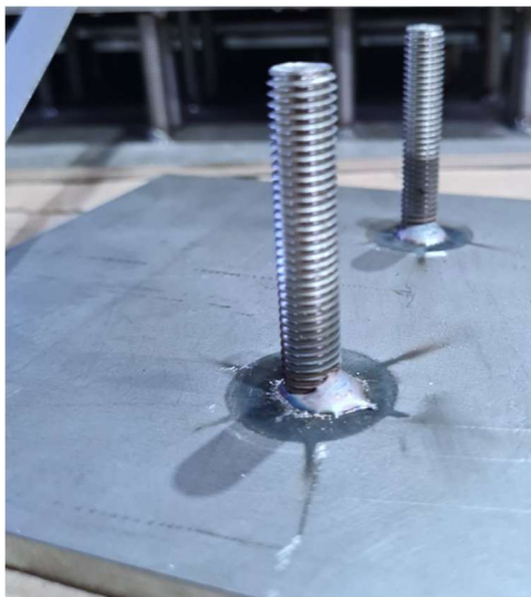
Slika 3.11. Nepravilan zavar svornjaka uzrokovan puhanjem luka
