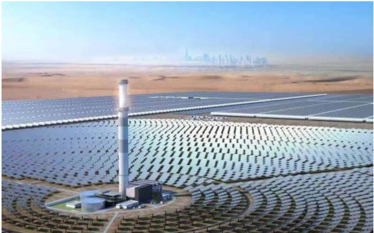
Slika 19 Elektrana sa solarnim tornjem
