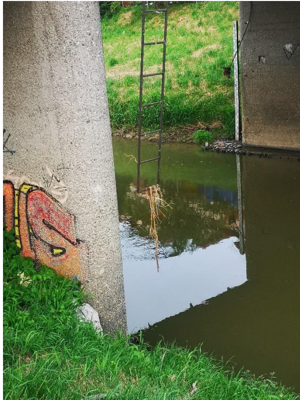
Slika 5.2.4. Prikaz ostataka materijala nošenog za vrijeme velikih voda [12]
