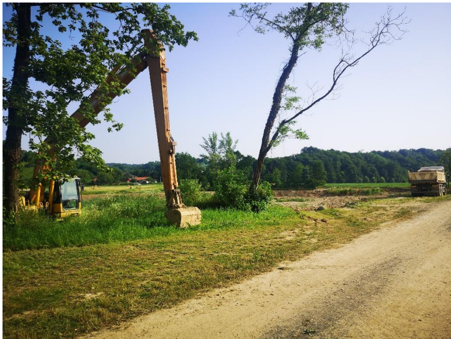
Slika 5.2.6. Građevinska mehanizacija kod rijeke Bednje [12]
