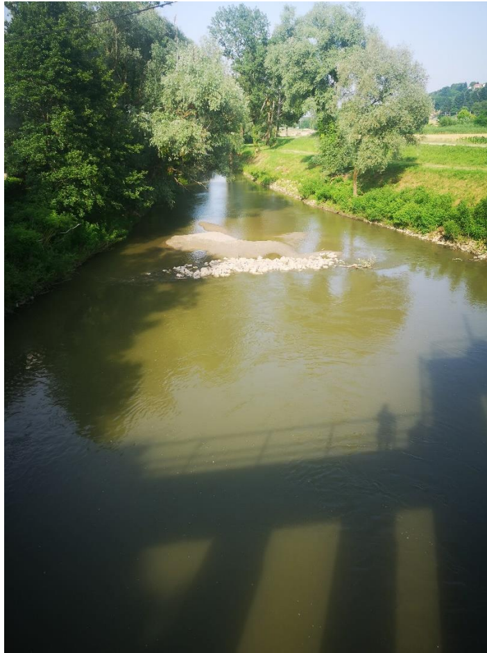
Slika 5.2.1. Riječni sprud na središnjem dijelu Bednje nizvodno od brane [12]
