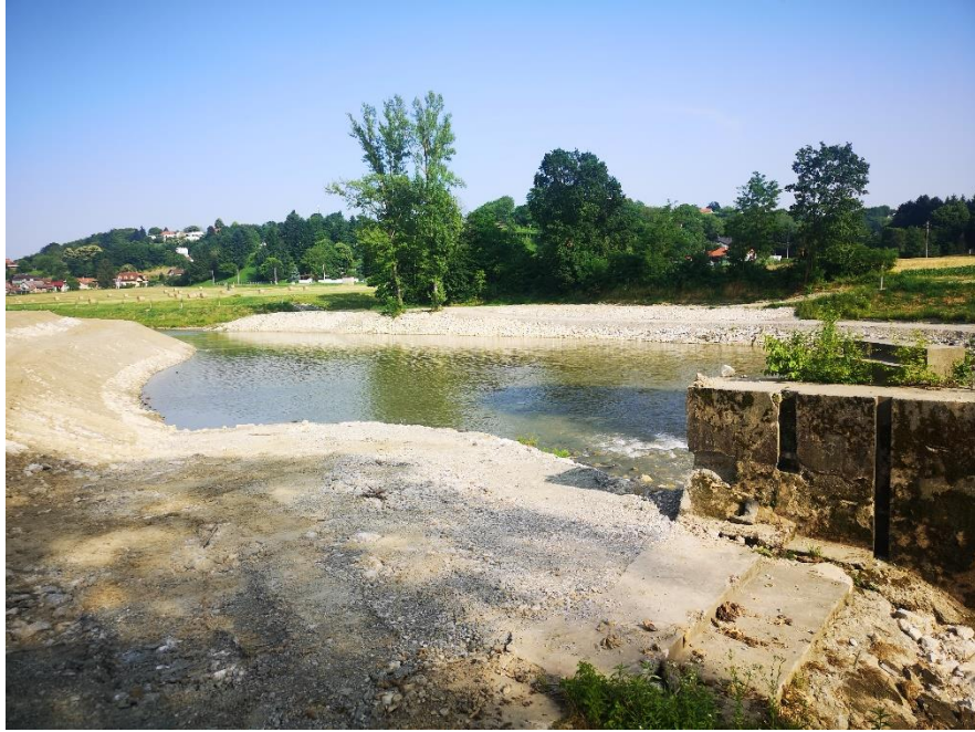
Slika 5.2.5. Obaloutvrda na rijeci Bednji [12]
