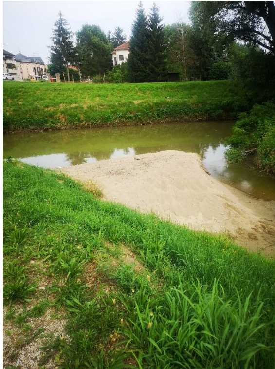
Slika 5.2.12. Pješčana sprud ušću derivacijskog kanala u Bednju (21.06.2023.)[12]
